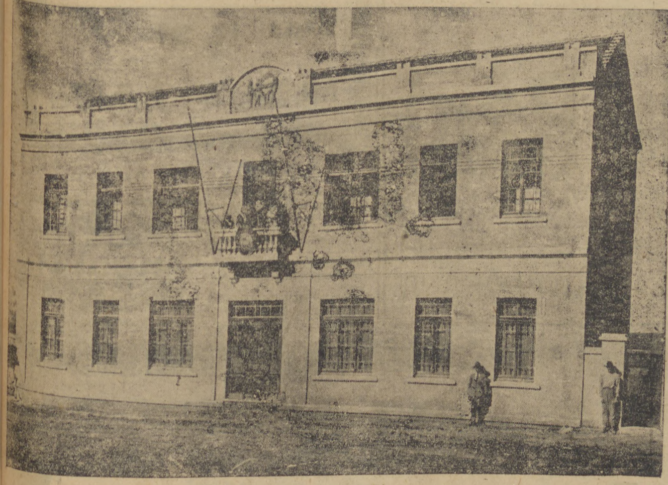
O magnifico predio que serve de sede ao Centro Operario Civico e Beneficiente
