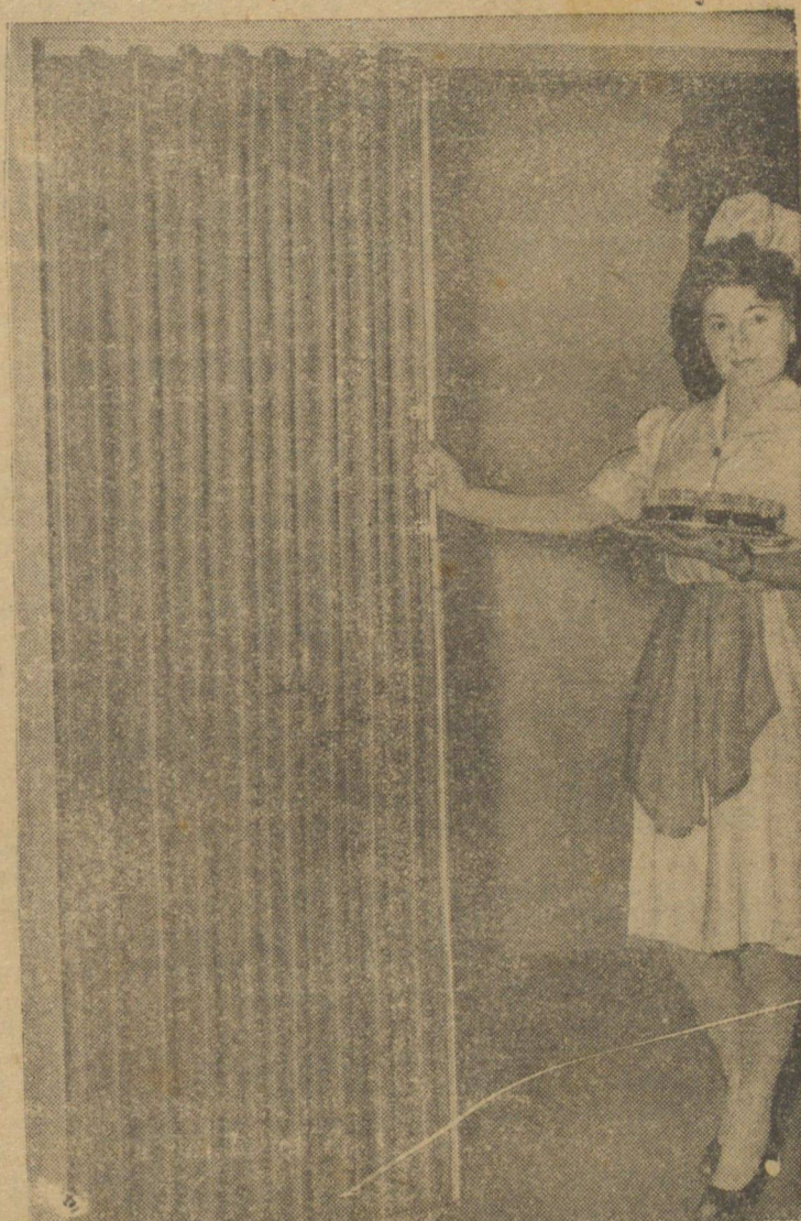
H. L. 9 — Numa exposição recentemente realizada em Londres foram expostas maneiras realmente novas de utilização de lã. A foto mostra uma porta corrida de lã, tratada com uma solução plastica contra umidade e insetos. BRITISH NEWS SERVICE
