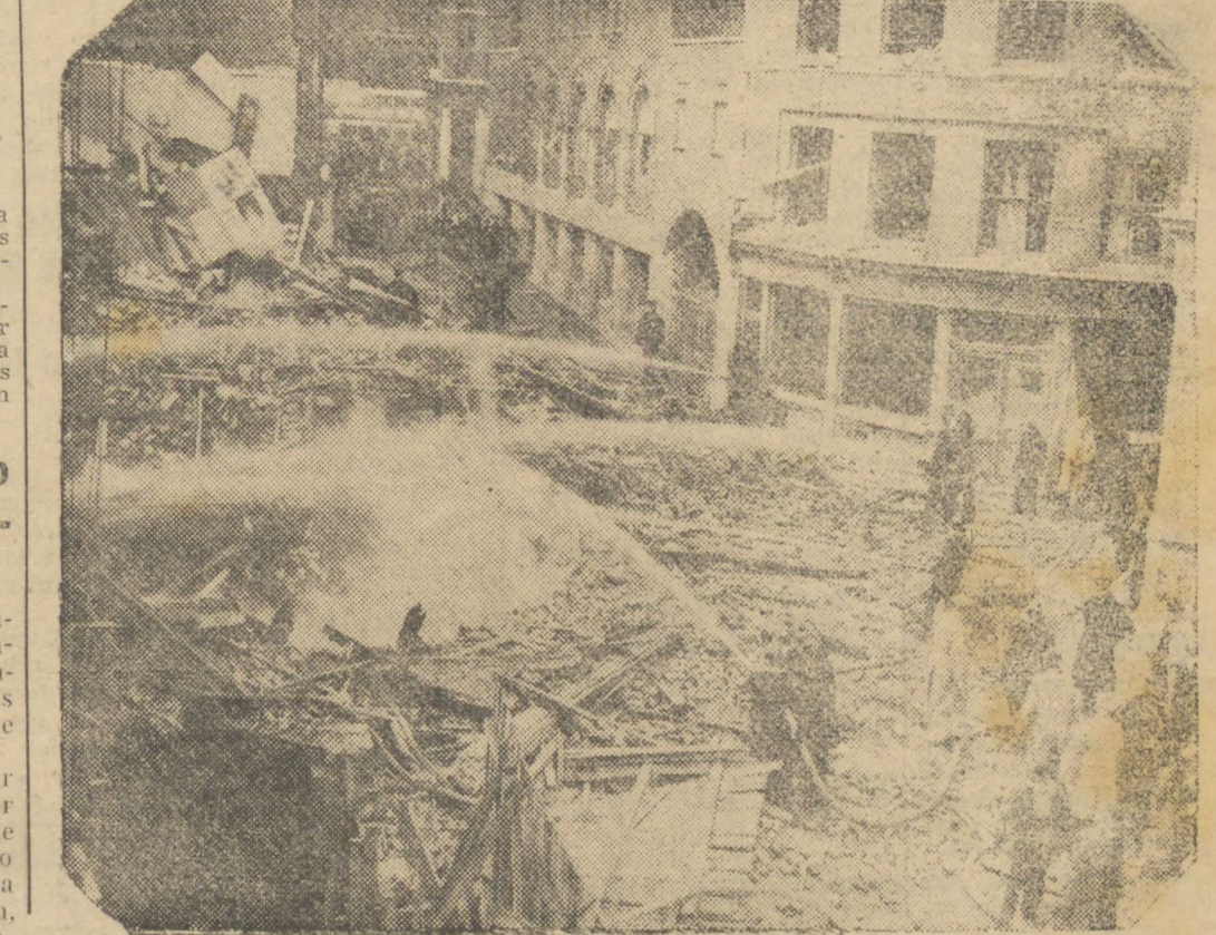
Trecho central da cidade de Varsóvia, parte atingida pelo bombardeio aereo do salemães
