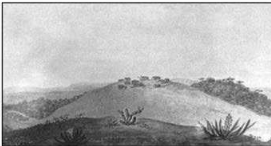
Figura 10 - Vista da Vila de Ponta Grossa no século XIX.
