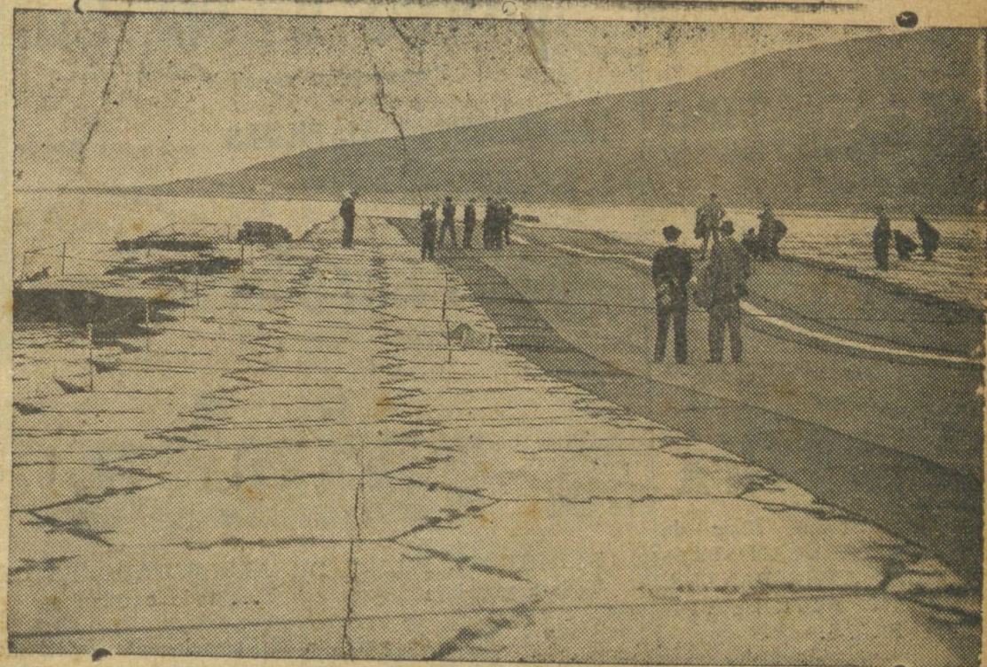
A FAIXA AEREA "LILY" (invenção britânica) — Uma das principais fotografias do aeródromo flutuante a faixa aérea "Lily" como é chamado. Podemos ver uma ondulação causada pelos movimentos do mar após a passagem de uma lancha a grande velocidade. — B. N. S.
